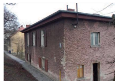
Zdj. 1. Jeden z budynków, które mają zostać poddane modernizacji
