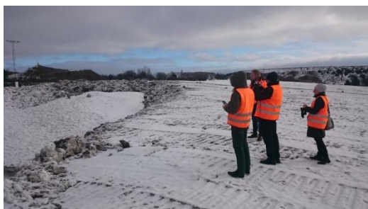
Zdj. 2. Rezerwar śniegu na potrzeby chłodzenia w okresie letnim na lotnisku w Ullensaker
