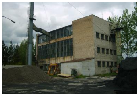
Zdj. 1. Stary budynek ciepłowni do modernizacji
