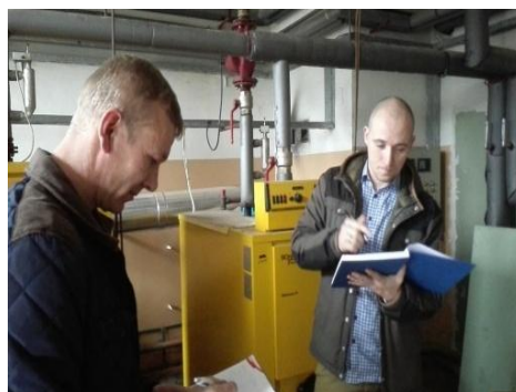
Zdj. 2. Wizyta przedstawiciela Oslo w jednym z budynków, w których mają zostać zainstalowane nowoczesne
