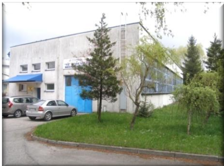
Zdj. 1. Planowana siedziba ośrodka - hala warsztatowa do modernizacji i adaptacji
