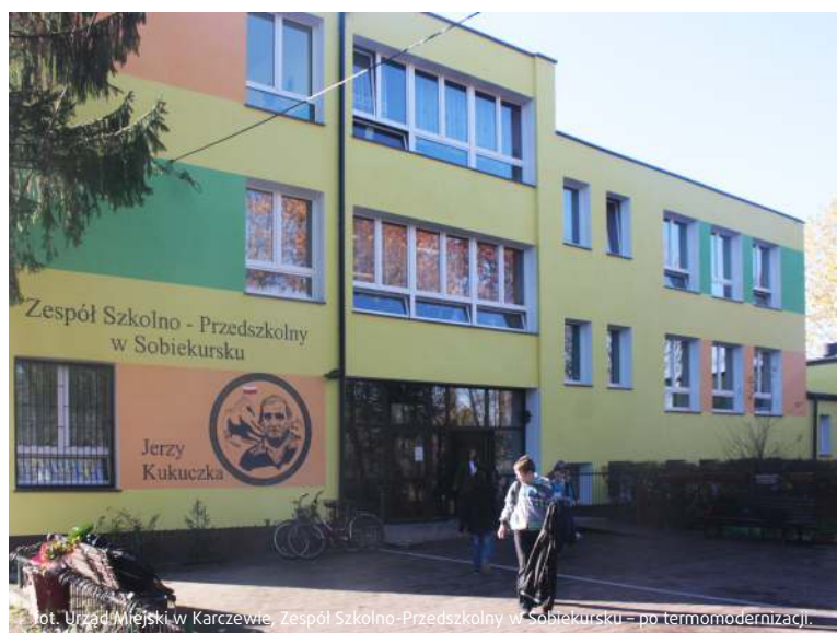
foto. Urząd Miejski w Karczewie, Zespół Szkolno-Przedszkolny w Sobiekursku – po termomodernizacji.
