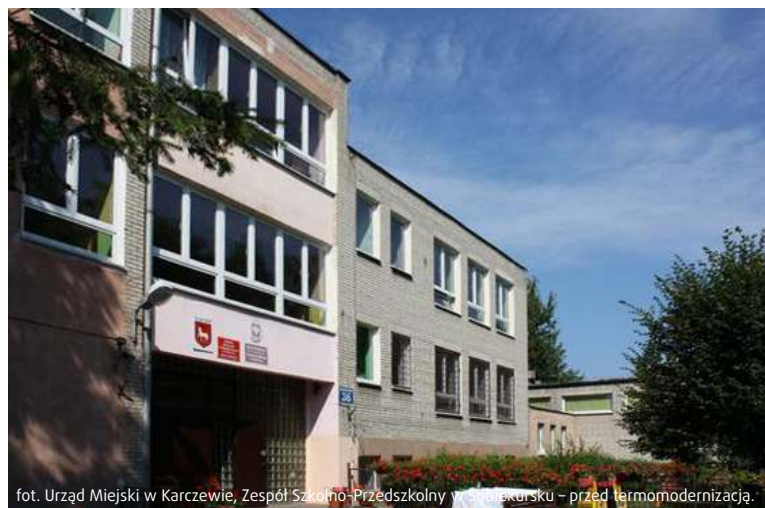
foto. Urząd Miejski w Karczewie, Zespół Szkolno-Przedszkolny w Sobiekursku – przed termomodernizacją.
