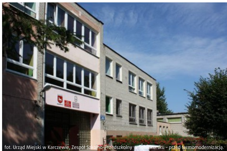
fot. Urząd Miejski w Karczewie, Zespół Szkolno-Przedszkolny w Sobiekursku – przed termomodernizacją.
