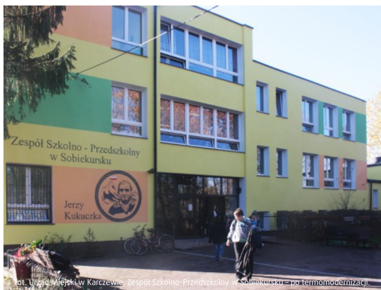
fot. Urząd Miejski w Karczewie, Zespół Szkolno-Przedszkolny w Sobiekursku – po termomodernizacji.
