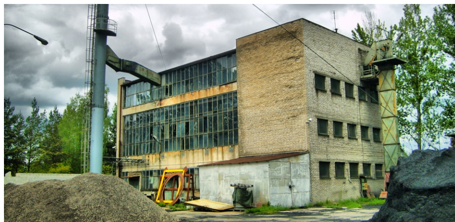
Stary budynek ciepłowni do modernizacji
